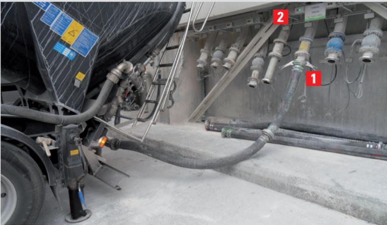
**1 Einblasschlauch an die zugewiesene Einblasstation anschließen und sichern.**
